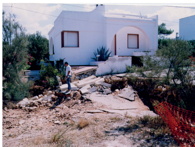
Figura 16 – Loc. Marina di Alliste (Provincia di Lecce). L'evoluzione di una cavità carsica costiera ha prodotto una situazione di grave dissesto.
