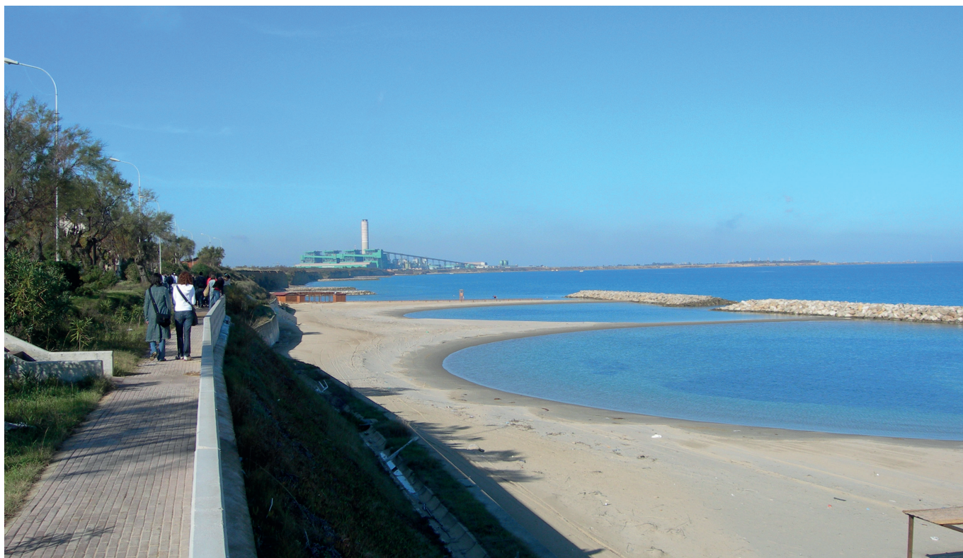
Figura 19 – Una situazione di rischio elevato è determinata dalla presenza di costruzioni in prossimità del ciglio della falesia di Cernone (loc. Campo di Mare), modellata su sabbie argillose. La mitigazione del rischio è stata ottenuta mediante costose opere di difesa costiera quali frangiflutti e muri di sostegno.
