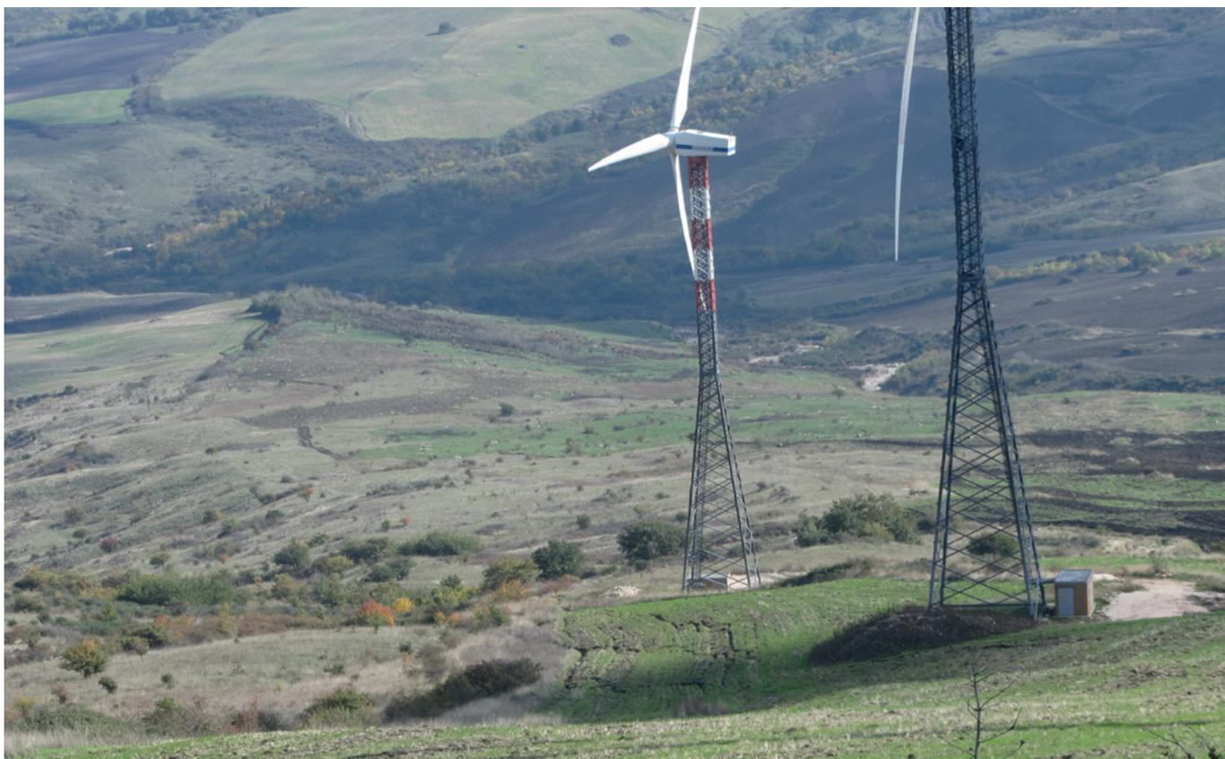
Figura 15 - Fratture estensionali che indicano un incipiente allargamento dell'area interessata dal dissesto in destra orografica della frana di Lama Lumelle (Novembre 2015). Le fratture sono giunte a lambire due torri eoliche.
