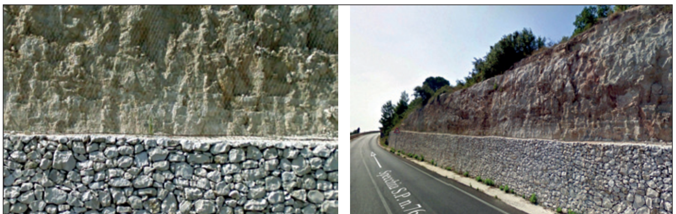
Figura 4 - Condizioni del pendio, in prossimità della sezione stradale n. 8 (stazioni geomeccaniche S 1 e S 2 ) dopo i lavori di stabilizzazione eseguiti dall'Amministrazione Provinciale di Lecce: a) muro di sostegno a gravità (foto a sinistra); b) rete metallica di contenimento (foto a destra).
