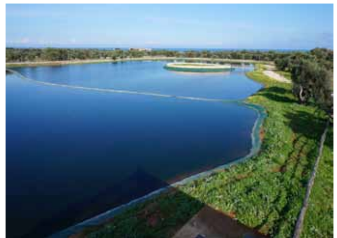
Figura 3 – Bacini di accumulo.
