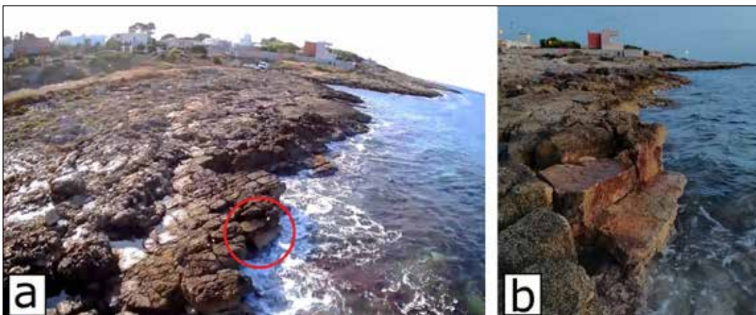
Figura 10 – a) individuazione di una nicchia di distacco (evidenziata dal cerchio) mediante ripresa da APR (località Torre Suda); b) immagine ripresa durante la successiva indagine di terreno.
