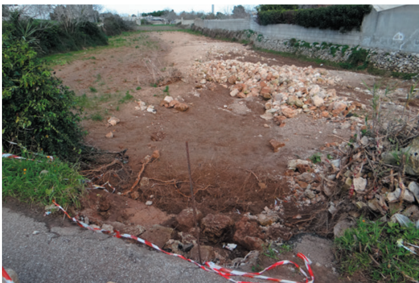
Figura 28 - I danni prodotti dall'esondazione del canale di bonifica avvenuta alla periferia meridionale di Minervino di Lecce durante l'evento del 18 novembre 2021.
