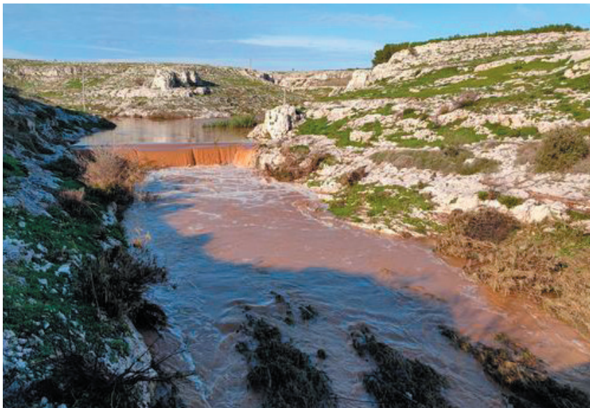
Figura 26 - La situazione poco a monte della briglia alcune ore dopo l'evento (fonte: www.ambienteambienti.com ).
