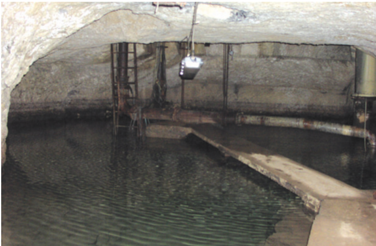
Foto 2 - Estremità settentrionale della galleria alla base del pozzo a sezione quadrata.
