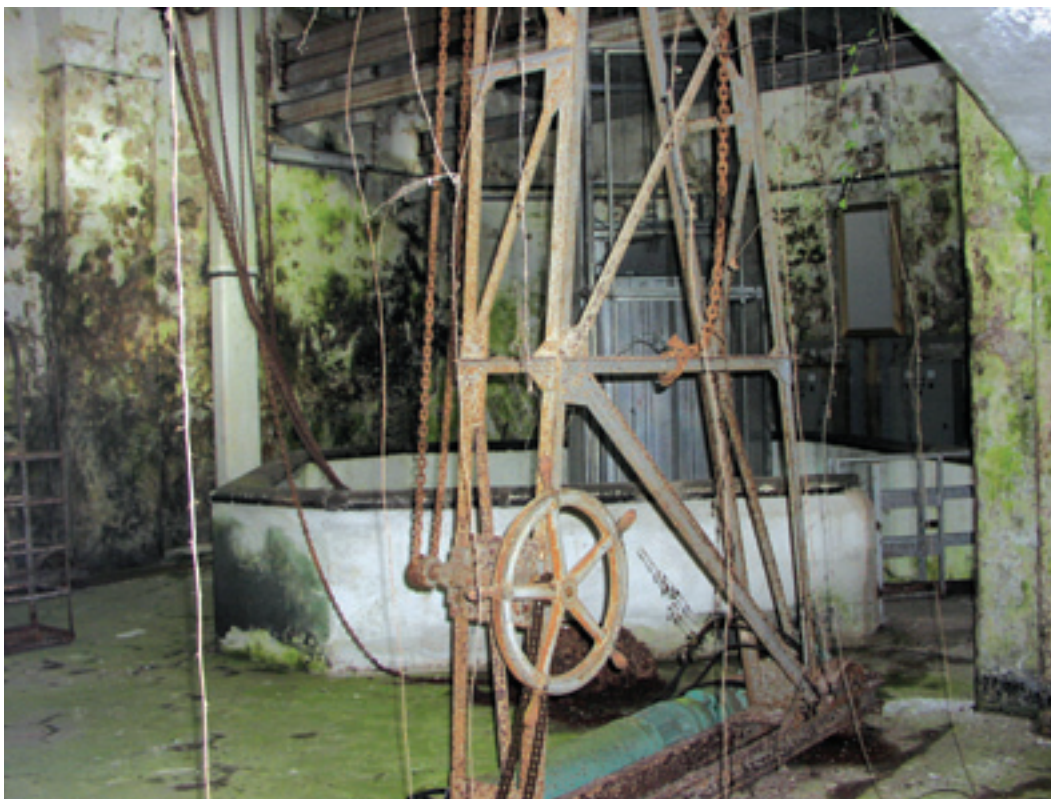
Foto 3 - Zona di accesso alla scalinata del pozzo a sezione quadrata.
