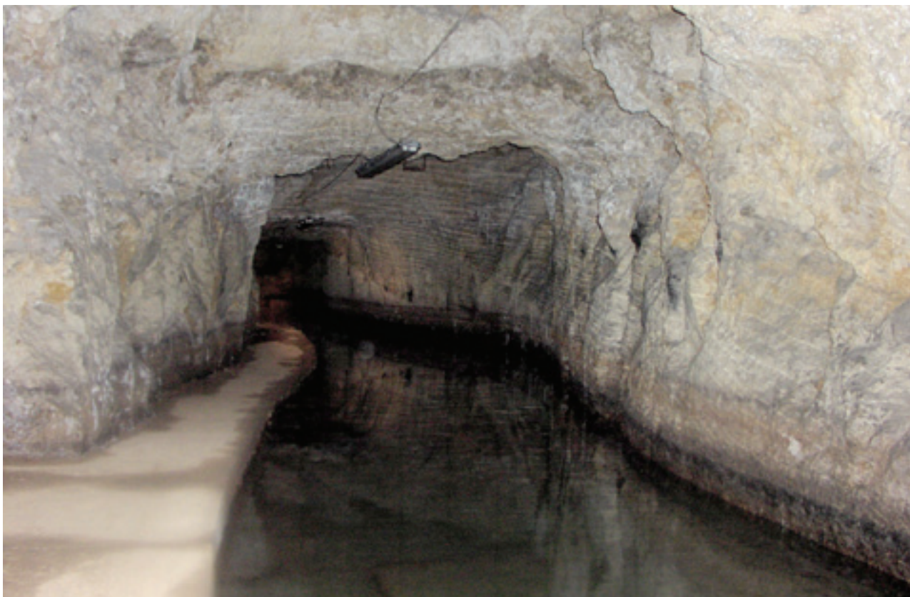
Foto 1 - La galleria drenante del pozzo Cozza-Guardati.
