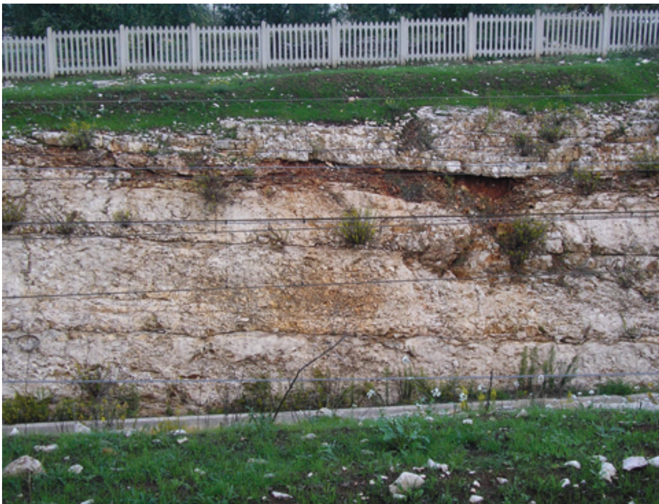
Figura 5 - Contatto stratigrafico tra il Calcarea di Bari (sotto) e il Calcarea di Altamura (sopra), lungo la trincea ferroviaria nei pressi di Parchi di Cristo. Si possono osservare le bancate degli strati correlabili con il Perlato Svevo al di sotto del contatto che risulta caratterizzato dalla presenza a luoghi di un deposito di terra rossa di spessore massimo di 1 metro.
