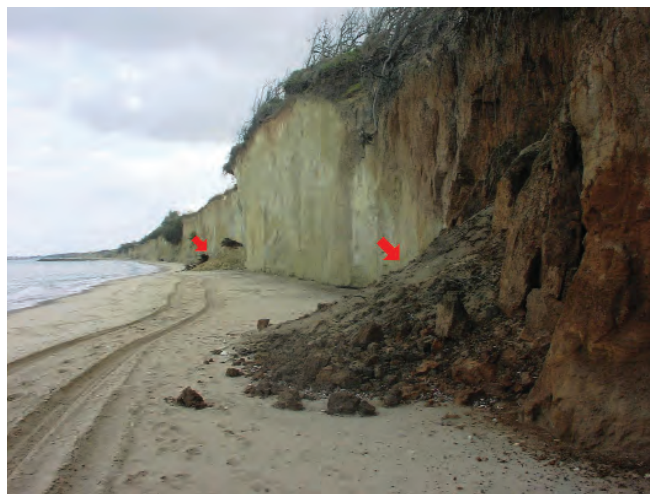
Foto 3 – Fenomeni di distacco e crollo alla base della falesia nei pressi Torre San Gennaro che interessano sia le sabbie argillose che le coperture continentali (6 maggio 2008)
