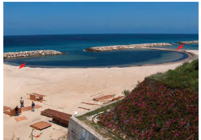
Foto 9 – Opere di difesa a scogliera, parallele alla linea di costa (near-shore); barriere emerse che attenuano l'energia del moto ondoso incidente e determinano la formazione di accumuli sabbiosi (tomboli "artificiali"); località Campo di Mare (San Pietro Vernotico - Br)
