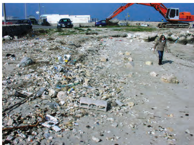
Foto 5 – Marina di Frigole (24 febbraio 2008). L’erosione e lo stato di abbandono della spiaggia pongono in essere “singolari” condizioni morfologiche della costa
