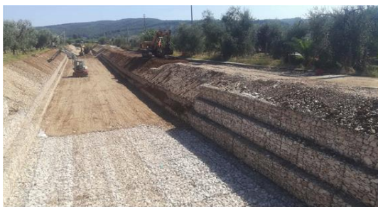
Fig. 9. Comune di Peschici provincia di Foggia, interventi in Canale Calena.
