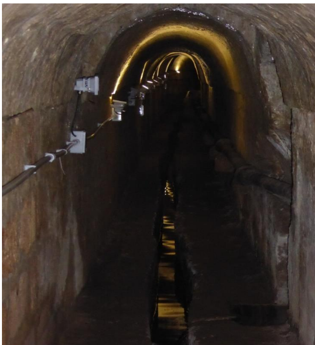
Fig. 12. Galleria drenante del qanat di Irsina.
