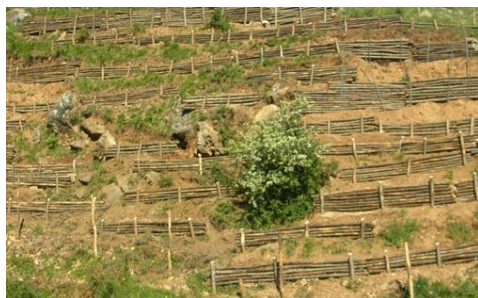
Fig. 7. Palizzate per il contenimento di piccoli scoscendimenti (San Marco in Lamis - FG)
