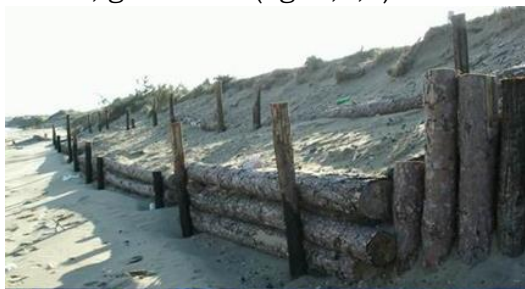
Fig. 5. Palizzate per il restauro della duna (loc. Bosco Isola - Lesina) prima e dopo la piantumazione di cespi di Ammofila.
