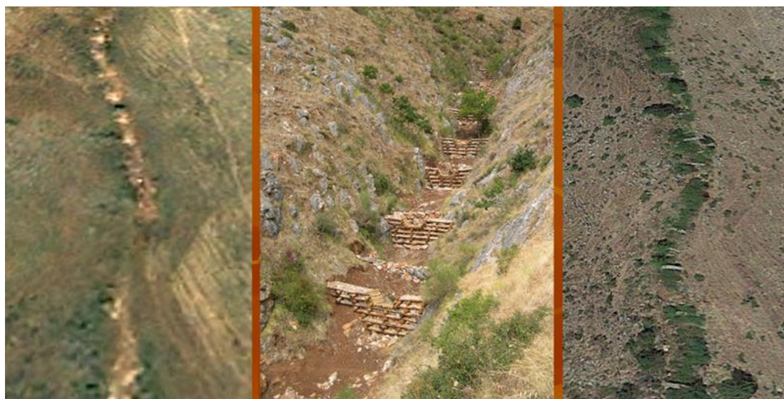
Fig. 10. Regimentazione con briglie in legname e pietrame del tratto montano di un torrente garganico, prima, durante (2008) e dopo (2015) l'intervento (San Marco in Lamis). Notare la spontanea rinaturalizzazione dell'alveo grazie al contenimento dei processi erosivi.
