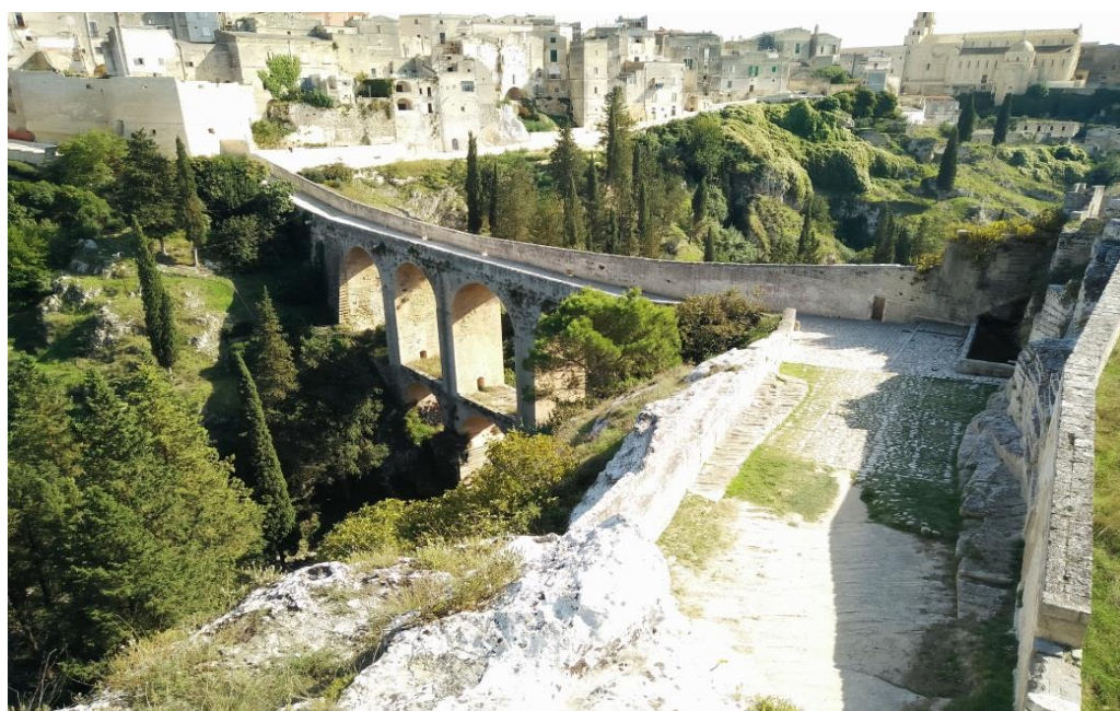
Fig. 11. Gravina in Puglia. Ponte canale che attraversa la gravina e porta l'acqua al bordo del centro abitato.
