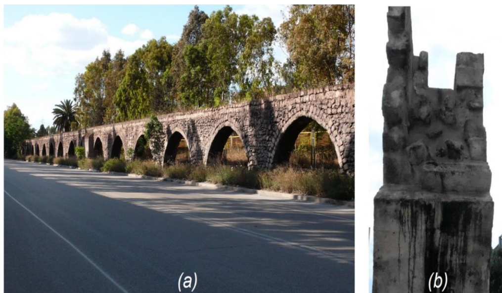
Fig. 17. Acquedotto del Triglio. Gli archi del tratto di attraversamento della depressione di San Brunone (a) e sezione trasversale (b).
