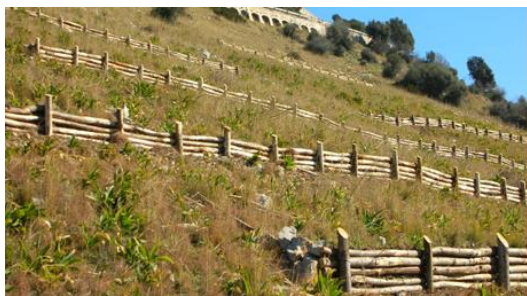
Fig. 6. Palizzate su versante (Rignano Garganico)
