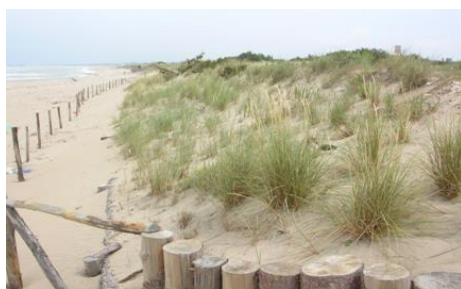
Fig. 5. Palizzate per il restauro della duna (loc. Bosco Isola - Lesina) prima e dopo la piantumazione di cespi di Ammofila.
