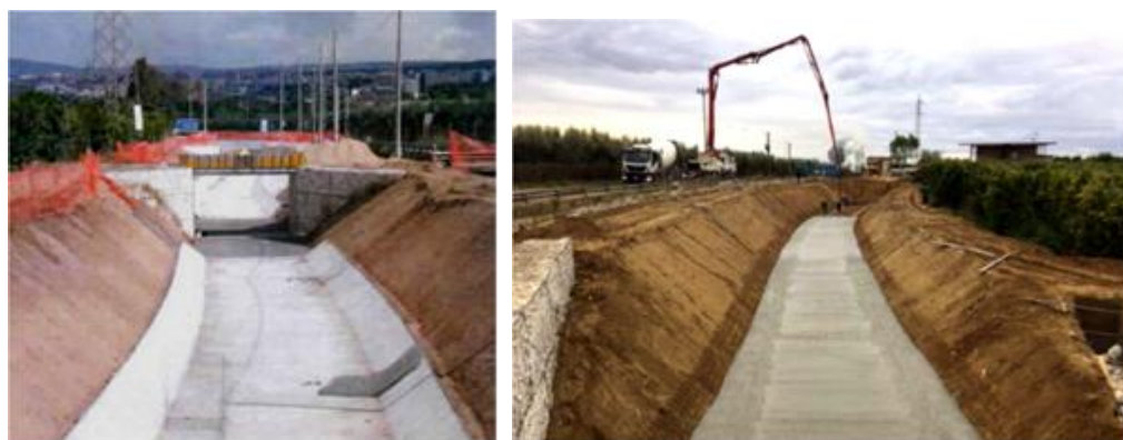
Fig. 16-17. Comune di Massafra, provincia di Taranto, interventi per la messa in sicurezza del territorio - Canale San Marco.
