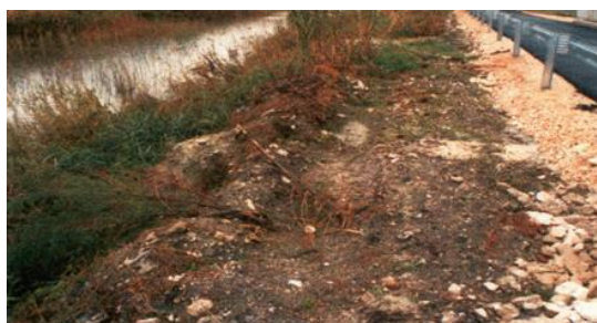
Fig. 8. Difesa spondale con palificata viva a doppia parete (loc. Molinella - Vieste).
