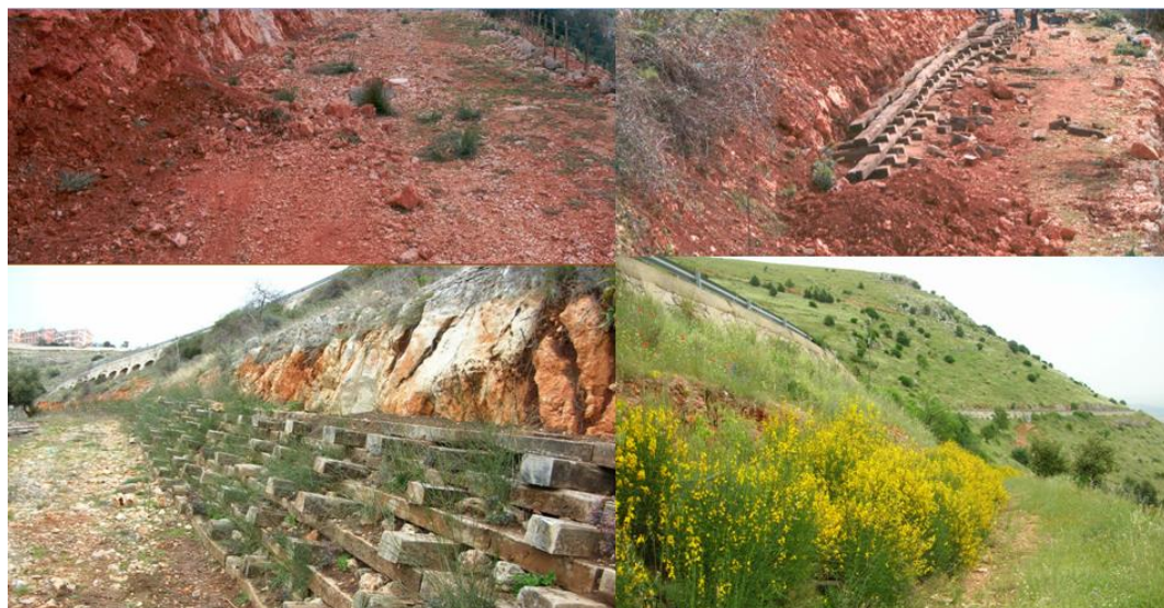
Fig. 9. Consolidamento e rinaturalizzazione di scarpata stradale con la tecnica della palificata viva a doppia parete, prima, durante e dopo l'intervento (Rignano Garganico).
