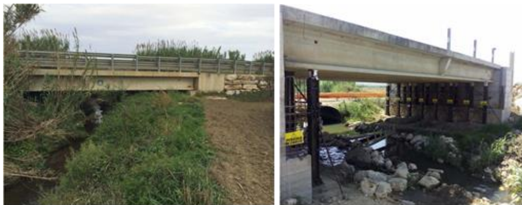
Fig. 5-6. Torrente Radicosa, provincia di Foggia, intervento di sistemazione idraulica.
