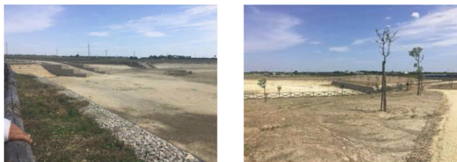
Fig. 18-19. Comune di Veglie, provincia di Lecce, interventi per la messa in sicurezza del territorio - Realizzazione vasca di laminazione.
