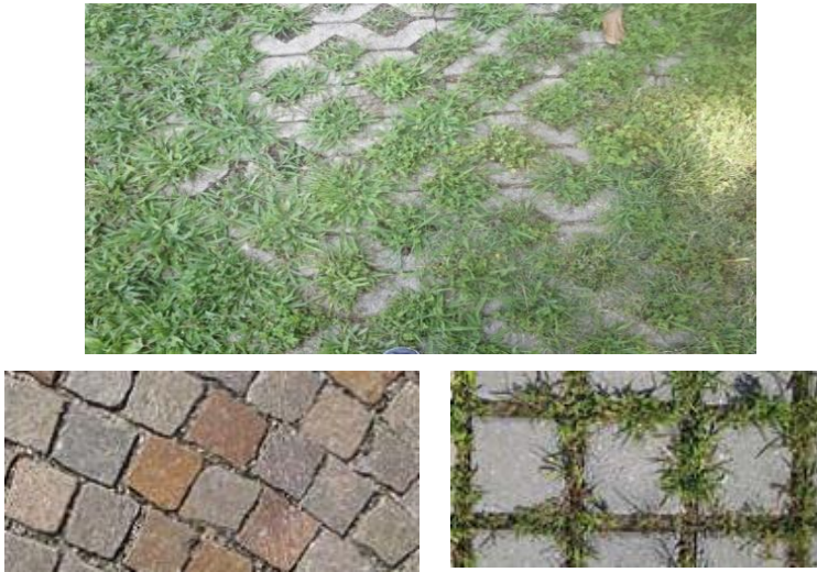
Fig. 4. Esempi di pavimentazioni permeabili.
