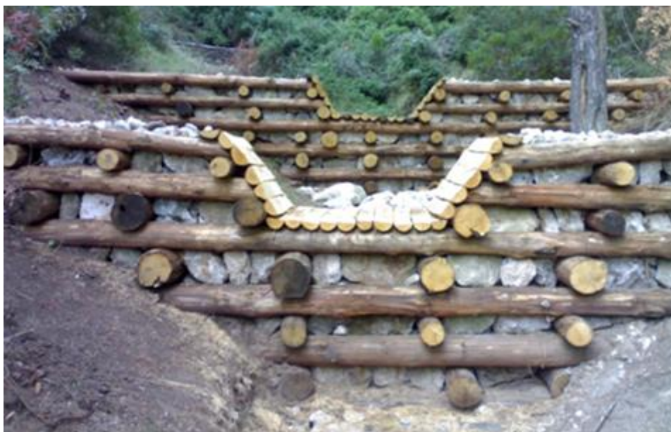
Fig. 11. Briglie in legname e pietrame (Isola di San Domino – Isole Tremiti)
