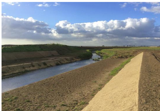
Fig. 13. Comune di Apricena, provincia di Foggia Canale Scolmatore – 2° Lotto.
