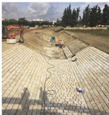
Fig. 20-21. Comune di Secli, provincia di Lecce, interventi per la messa in sicurezza del territorio - Realizzazione vasca di Laminazione e canale scolmatore.
